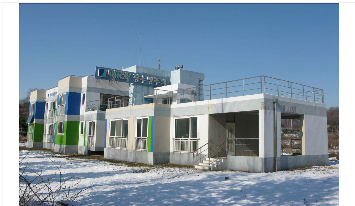
[그림] 장수명 주택 외벽 시공사례 예시
